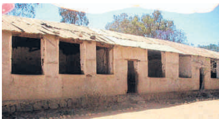
Die alte Schule hat das Team saniert.
