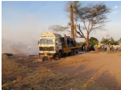
Bohrung bei den Messpunkten VES 1 und VES 5: Granit (weißer Staub) - Bohrkopf
