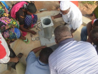
Sicheres Wasser für die Schüler der Secondary School in Mtunduru (VES 10): Installation einer AfriDev-Handpumpe und Fördern von sauberem Trinkwasser
