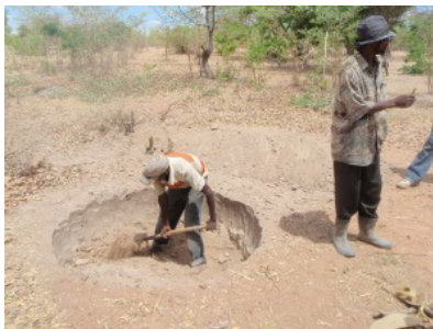
Ausgrabungsarbeiten bei VES 4: Wasser in 4 m Tiefe - Zementringe zum Auskleiden des Brunnens
