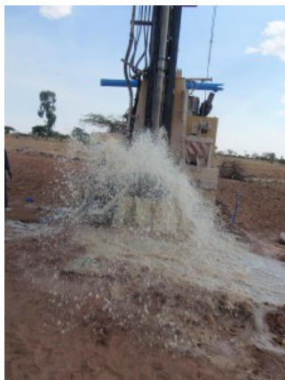
Wasser (Messpunkt VES 3 in 60 m Tiefe) und Party bei Messpunkt VES 10 (Wasser in 46 m Tiefe)
