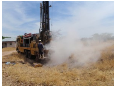
Bohrung bei den Messpunkten VES 1 und VES 5: Granit (weißer Staub) - Bohrkopf
