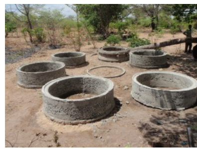
Ausgrabungsarbeiten bei VES 4: Wasser in 4 m Tiefe - Zementringe zum Auskleiden des Brunnens
