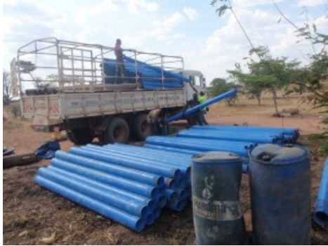
PVC-Rohre für die Auskleidung, Einfassung und Versiegelung der Bohrlöcher (VES 3 ,VES 10)
