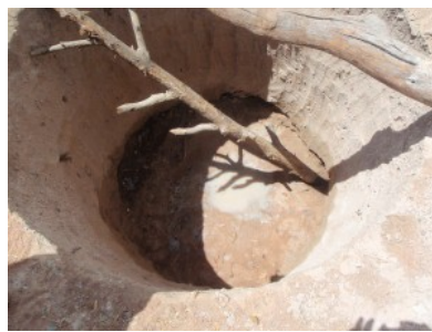
Ausgrabungsarbeiten bei VES 4: Wasser in 4 m Tiefe - Zementringe zum Auskleiden des Brunnens
