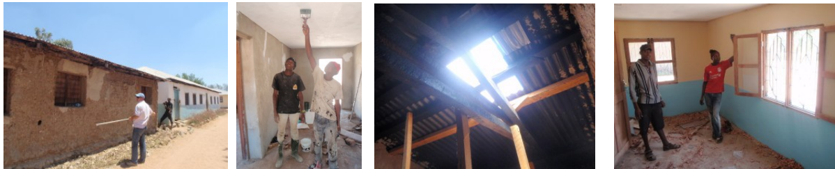
Renovierungsarbeiten an zwei Lehrerhäusern
