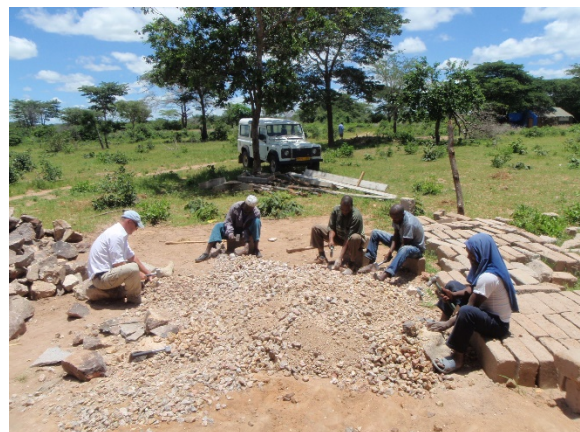
Transport von Sand und Steinen mit Hilfe des Distrikts-LKW und Kleinschlagen der Steine
