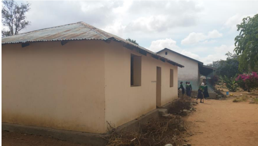
Abbildung 9: Die Lehrerhäuser sind in einem guten Zustand.
