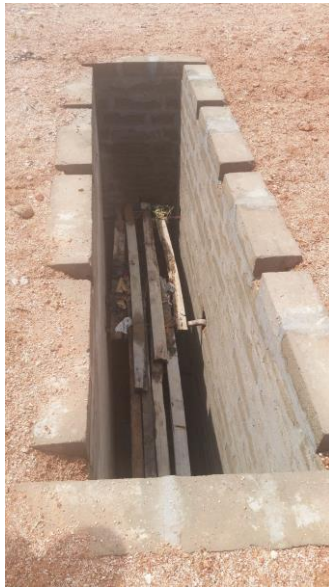
Abbildung 20: Grube und Fundament des neuen Toilettenhauses.
