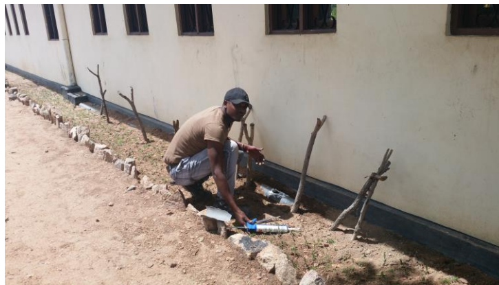
Abbildung 16: Spontane Reparatur einer der beiden Regenwasserabflüsse zum Tank.
