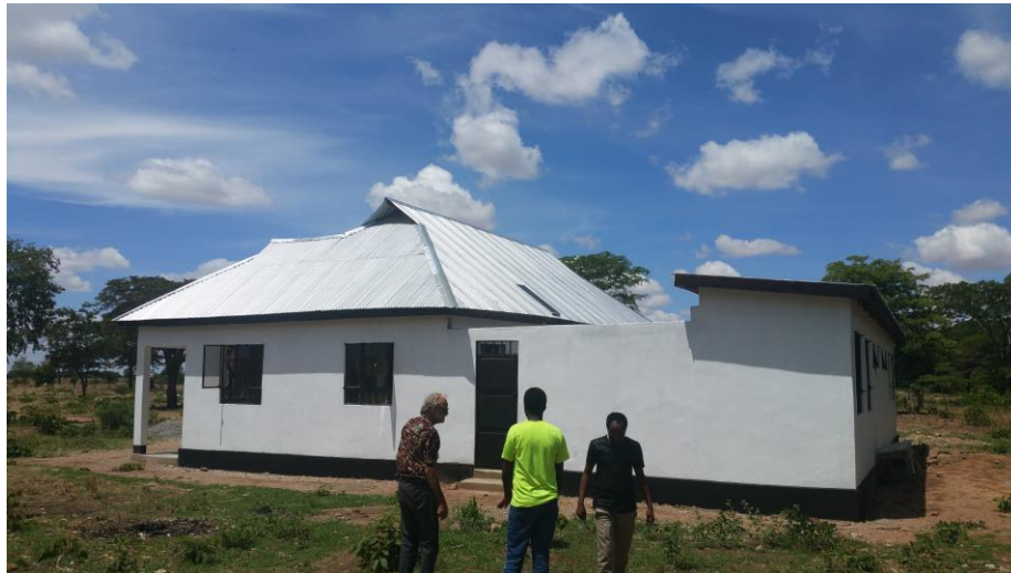
Abbildung 24: Neu errichtetes Wohnhaus des medizinischen Personals.
