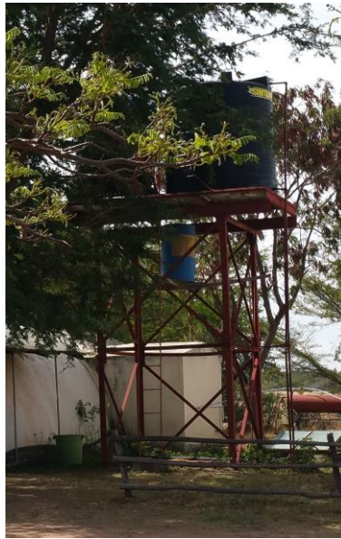
Abbildung 28: Typischer Wassertank zur Pufferung von Trinkwasser.
